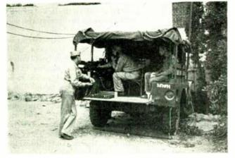
MOBILE FM TERMINAL STATION IN TRUCK COULD MOVE QUICKLY TO NEW LOCATION AS BATTLE LINES CHANGED
