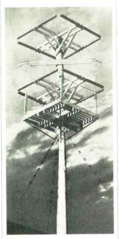
FIG. 35. TELEVISION SOUND TRANSMIT-TING ANTENNA AT MAIN STATION
