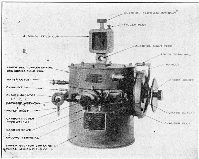
Fig. 45.—The Arc Converter.
