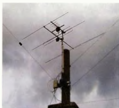
Obr. 4. Anténa 3EL Yagi pro FM CCIR
