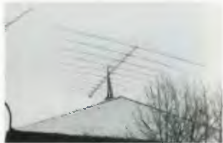
Obr. 2. Tuto LPD anténu pro pásma 14 až 30 MHz si OK1GW vlastnoručně zhotovil v roce 1995. Stabilita dlouhých štíhlých prvků byla zabezpečena závěsnými lany, ukotvenými nad nosným ráhmem antény
