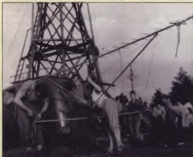
Obr. 6. Montáž antény 21EL Yagi OK1KRC (tehdy nejdelší v Evropě) pro pásmo 430 MHz, Den rekordů 1954, Klínovec. Zleva Jindra, OK1VR, Ing. Horna a Jiříčka, XYL OK1VR
