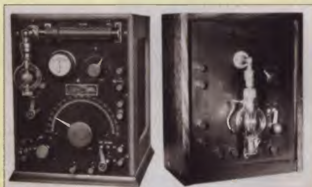
Obr. 30. (Vpravo) Přijímač „Ultraudion“ (vlevo) a vysílač menšího výkonu „Oscillion“ z de Forestovy dílny
