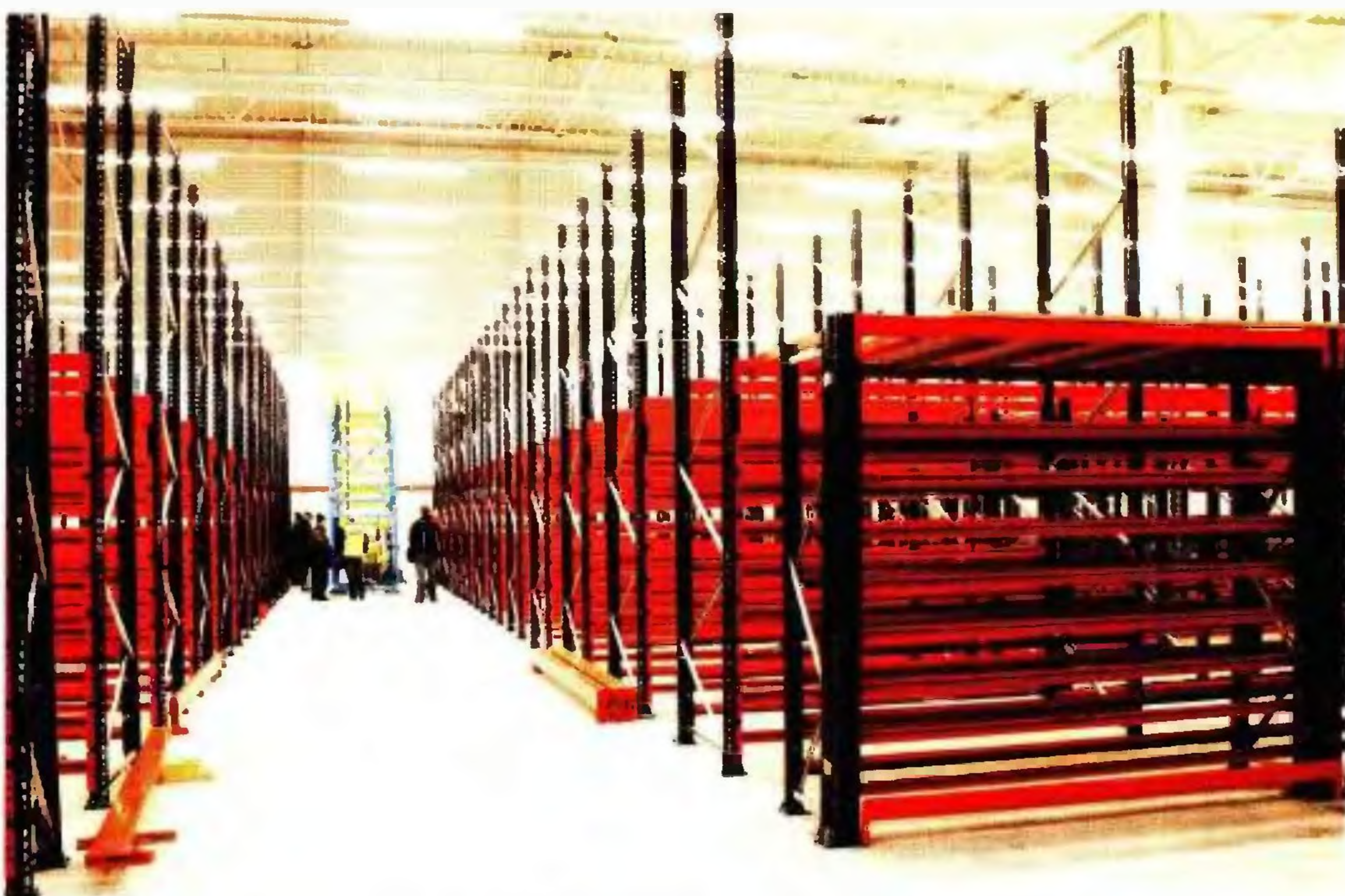
Obr. 1. Budování nového centrálního skladu
