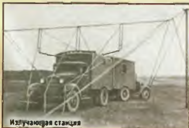
Obr. 1. Vysílací část radarového systému RUS-1, což byl fixní systém s rozměrnou anténou vysílající do dvou směrů (kolmo na anténu)
