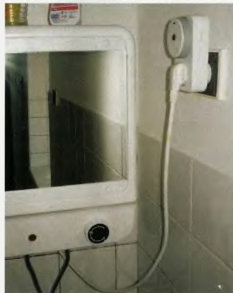
Obr. 3. Bojler (vľavo) a tlačidlový časový spínač (vpravo hore)
